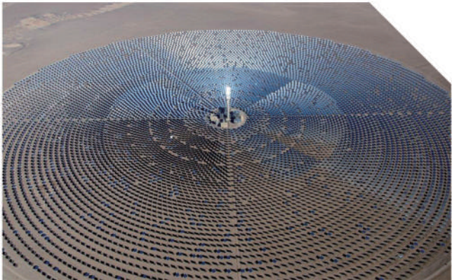
塔式聚光系统 Solar Tower CPV System
